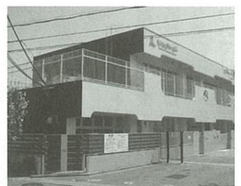
大規模改修できれいになった園舎
